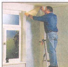
11 Полотнища обоев приклеивают строго по обозначенной линии. У потолка обои должны иметь припуск 2–3 см.
