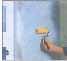
15 Приклеенное полотнище обоев прикатывают упругим микропористым валиком или приглаживают обойной щеткой от середины к периферии.
