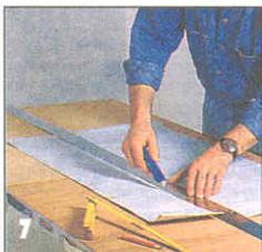
7 Для раскроя полотнища по ширине его кладут на стол и ножом с помощью стальной линейки разрезают вдоль.
