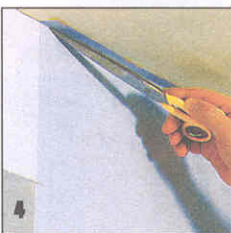
12 У потолка обои вдавливают ножницами в угол, намечая линию сгиба.
