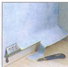
13 Аналогично обрезают обои и внизу у плинтуса. Для обрезки лучше использовать специальную обойную V-образную шину (правда в продаже они бывают редко и стоят довольно дорого).
