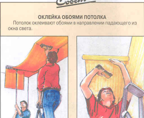
9 При оклейке обоями потолка лучше работать вдвоем. Помощник может, например, прижимать чистой шваброй конец очередного укладываемого полотнища обоев к кромке предшествующего полотнища, уже приклеенного.
