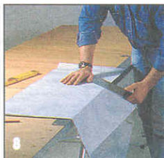
8 Полотнище обоев можно разрезать вдоль также специальным резакром, предварительно прикрепив на краю стола (верстака) стальную шину.
