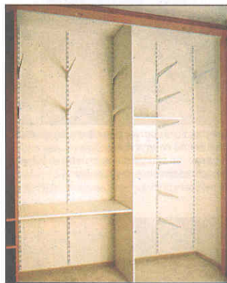
Внутреннее устройство шкафа. Полки опираются на кронштейны, вставленные в шлицы настенных шин. Перегородка крепится к стене на уголках. Дверки не связаны с внутренними элементами шкафа и перемещаются по потолочным и напольной направляющим.
